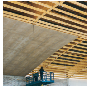
Будівництво мансардних приміщень
