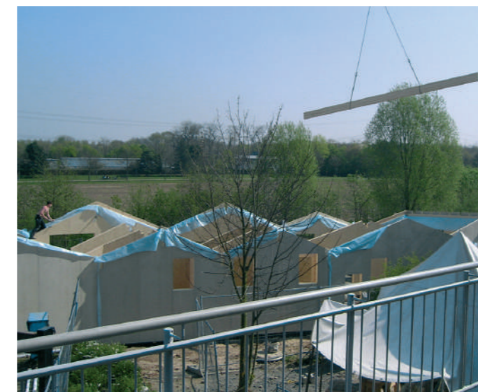
Плити Duripanel в дерев'яному та дерев'яно-каркасному будівництві.
