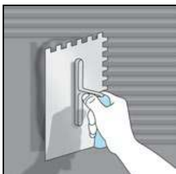
Малюнок 14.7 Армуючий шар Cementex PM Finisher по плитам CEMENTEX
