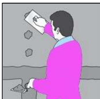
Малюнок 14.6 Шпаклівка Cementex PM Finisher на місцях кріплення плит CEMENTEX
